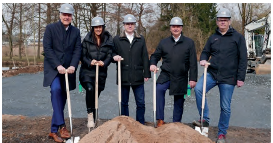
Am 16.03.2022 fand der erste Spatenstich für eine Apartmentanlage mit 28 Wohneinheiten statt, die den Mitarbeitenden eine betriebsnahe Unterkunft bieten soll (v.l.n.r.: Michael Ponnath, Inhaber und Geschäftsführer, Anne Ponnath, Teamassistentin, Stefan Gebhardt, Geschäftsführer Verwaltung, Michael Ascherl, Geschäftsführer Produktion und Technik, Stefan Hader, Geschäftsführer der BKH Wohnbau)
